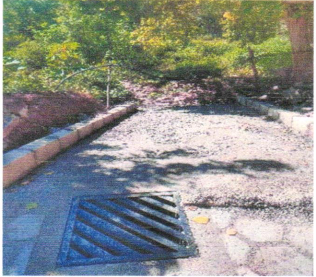
Vista de la calle Lázaro Cárdenas donde se ve el adoquín, banquetas, guarniciones y pintura
