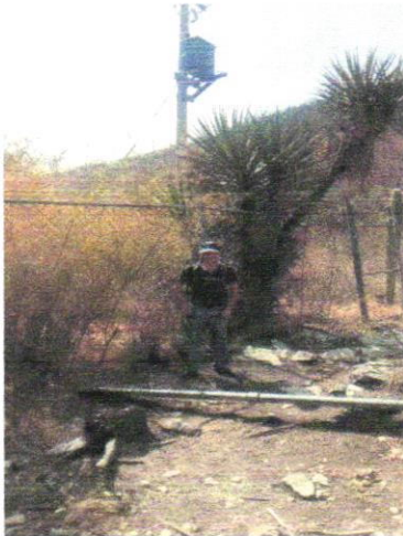
Vista de caseta de tubería
