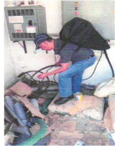
Vista de caseta de control donde se cambio la instalación eléctrica por nueva
